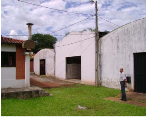
Parte frontal de los Depósitos.
