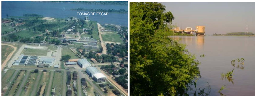
Toma de Agua de ESSAP, aguas abajo del emprendimiento UNIÓN-CARGIL
