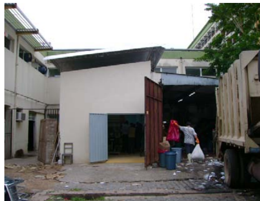
Vista del sitio de implantación del equipo procesador de residuos patológicos.
