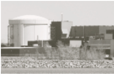
La centrale nucléaire de Gentilly-2.
